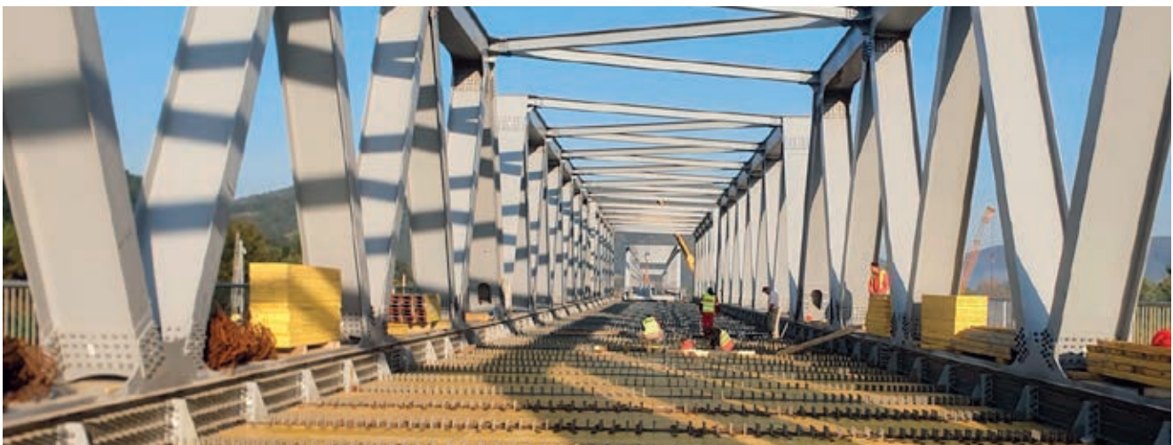
Sanierung der Bahnstrecke bei Simeria, Rumänien
